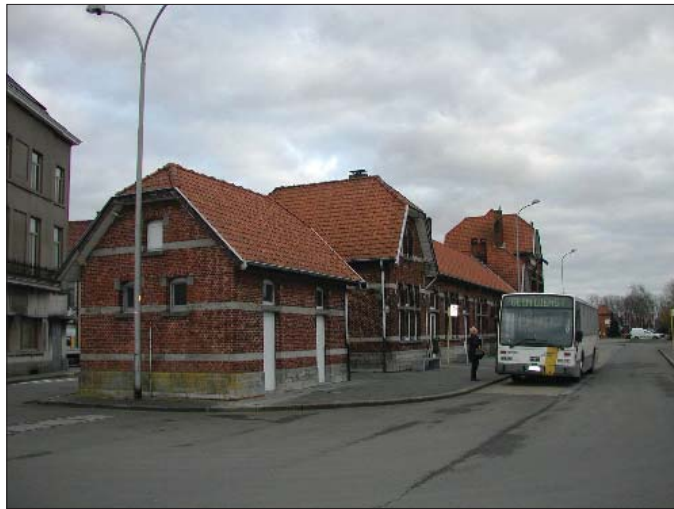
Zicht op de westzijde van het beschermde stationsgebouw met de hoofdbusstopplaats van de gemeente Avelgem.
